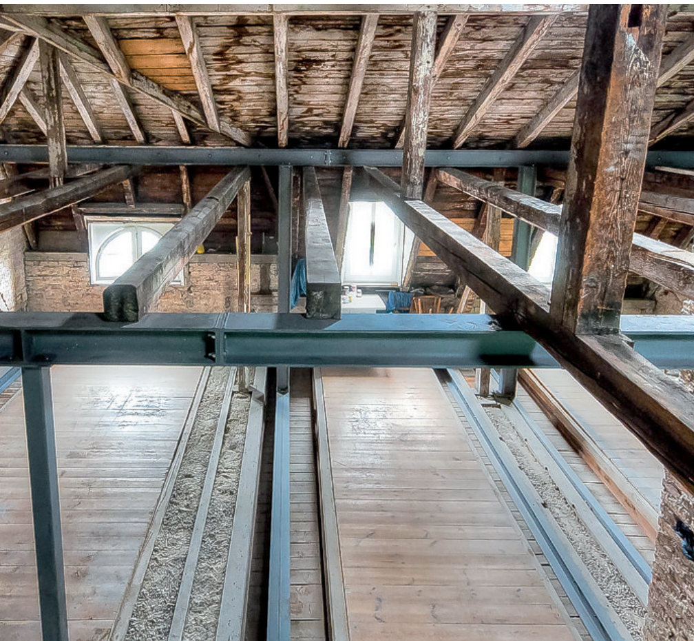
(4) Stahlträger unterstützen die Konstruktion
