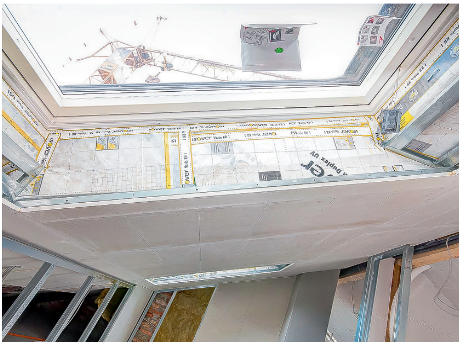
(6) Luftdichte Montage der Dachflächenfenster
