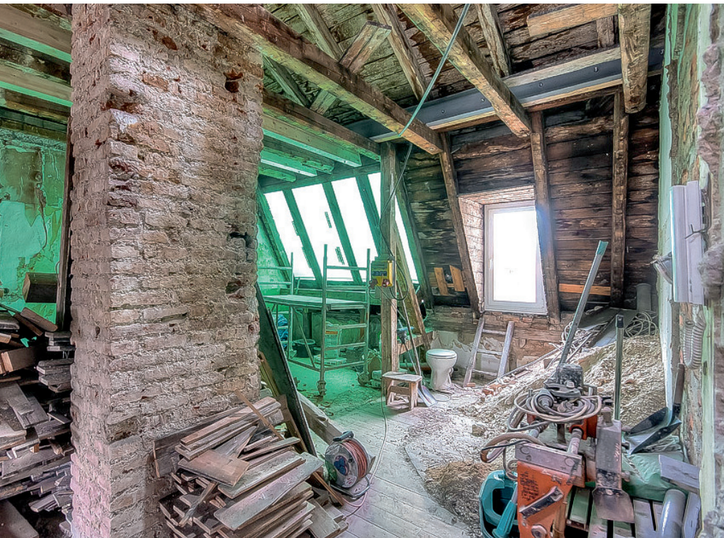
(3) Entkernung Dachgeschoss
