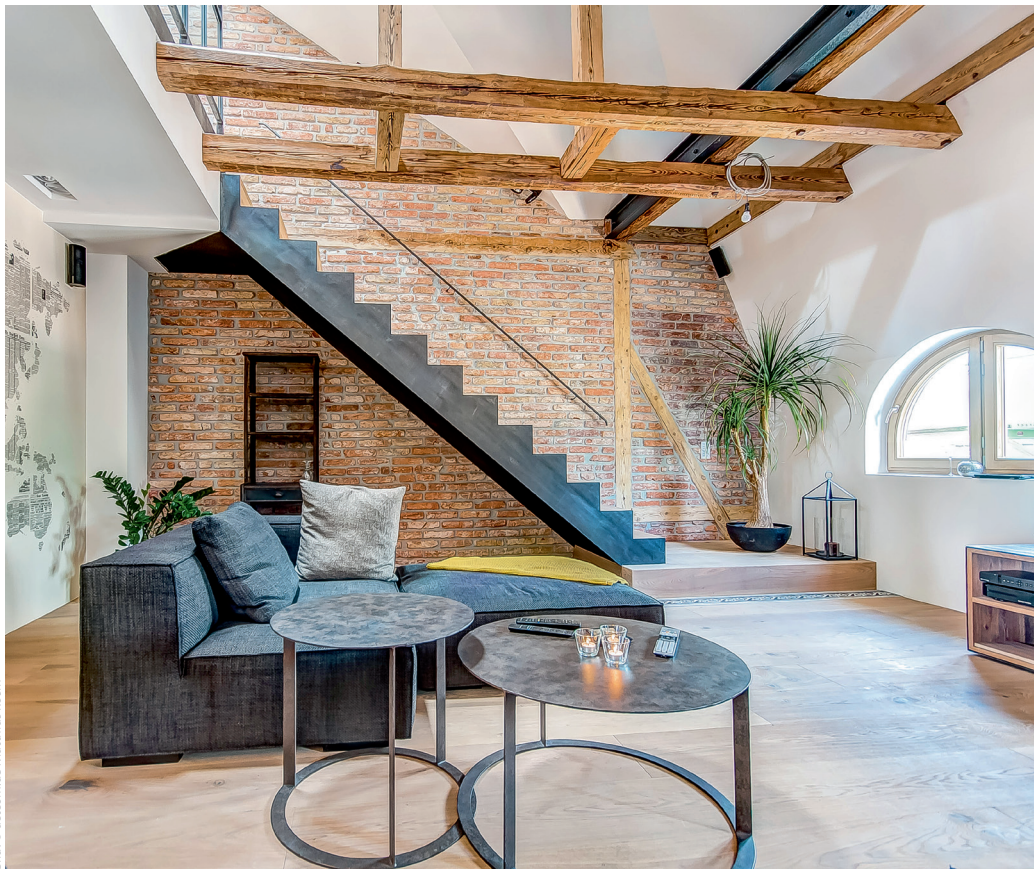
(10) Neue Faltwerktreppe mit gewachsenen Schwarzstahlwangen
